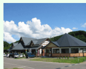
道の駅おりつめ 「オドデ館」
